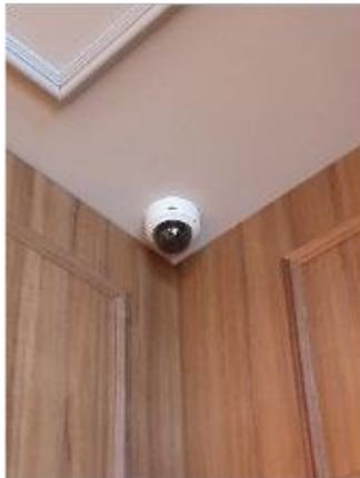
Para cubrir grandes áreas en las que el punto de interés cambia constantemente se instalan 2 cámaras de la serie Panorámica SCATI EYE. El modelo SEM-3701RS-EAO ofrece una gran calidad de imagen gracias a sus 6 Mpx de resolución y su objetivo de gran angular permite grabar todo el campo visual sin puntos ciegos.
