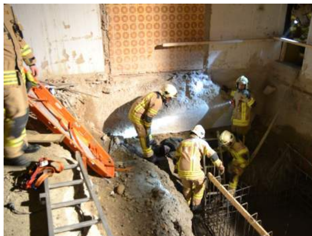
27. Februar – Personenrettung auf Baustelle
