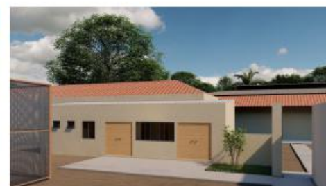
BWC's, Copa, Refeitório e Vestiário
