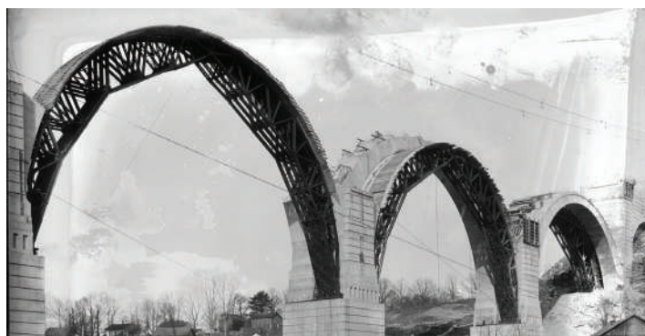
En 1914, los obreros trabajaban sin descanso para continuar la construcción (foto cortesía de los Archivos del Sitio Histórico Nacional de Steamtown).
