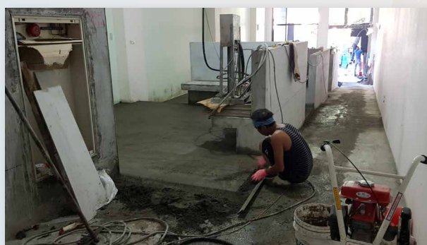
■ 2021-07-10 1F 地磚鋪設
