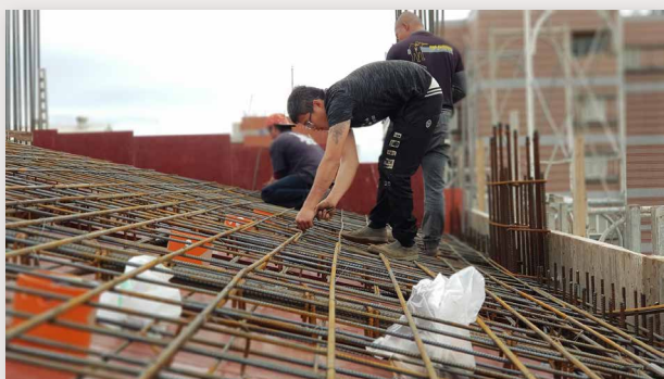
■ 2020-12-04 小禮拜堂屋頂鋼筋綁紮
