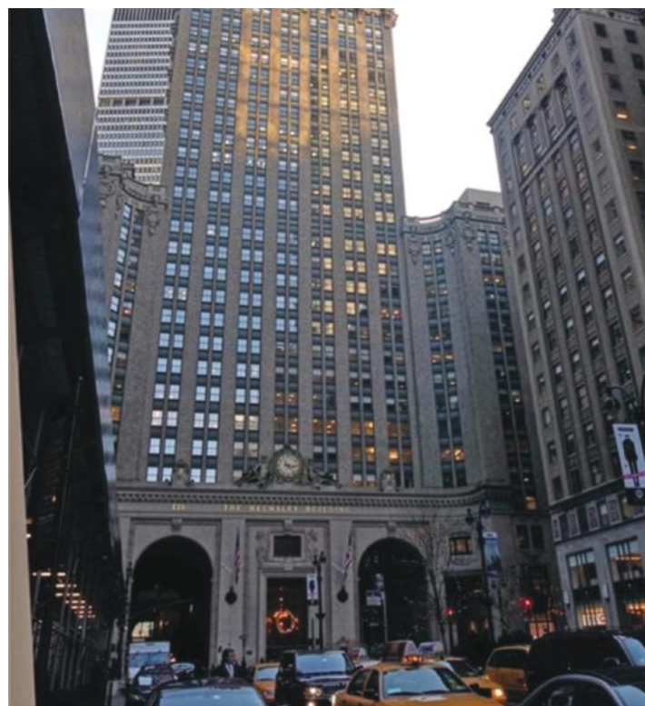
Fig. 2: El viaducto de Park Avenue, una de las vías más transitadas del centro de Manhattan, atraviesa la base del edificio Helmsley, de 35 pisos. Dado que los techos de los dos túneles forman parte del sistema de muros exteriores de este edificio de estilo Beaux-Arts de 35 pisos, deben cumplir con la normativa del Programa de Inspección y Seguridad de Fachadas de la ciudad de Nueva York. (foto cortesía de Thornton Tomasetti)
