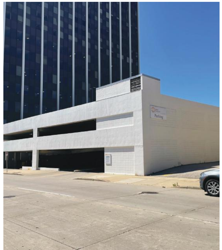
Estructura de estacionamiento de Catholic Financial Life.
