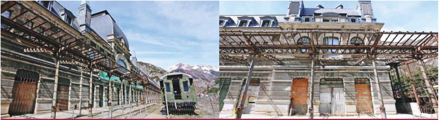
El Hotel de la Estación de Canfranc antes de su restauración.
