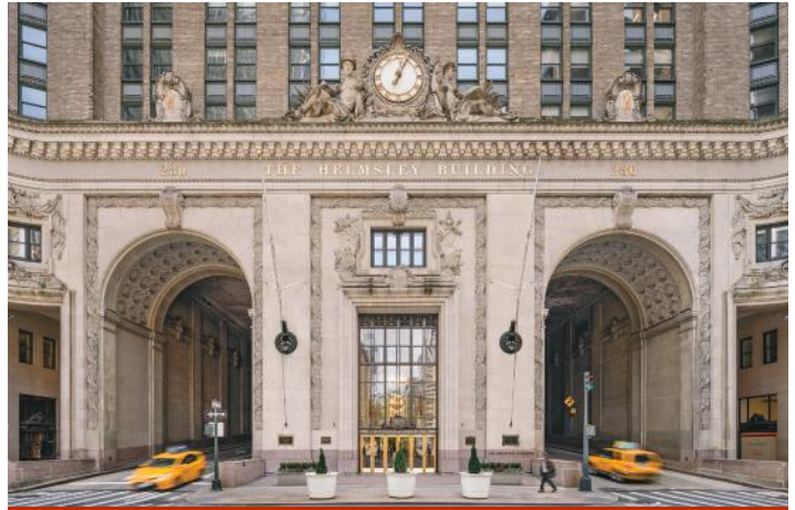
Fig. 5: Gracias al trabajo en equipo, a una planificación rigurosa, a herramientas avanzadas y a una gran experiencia, el techo del viaducto está listo para los próximos 100 años (foto cortesía de Thornton Tomasetti)
