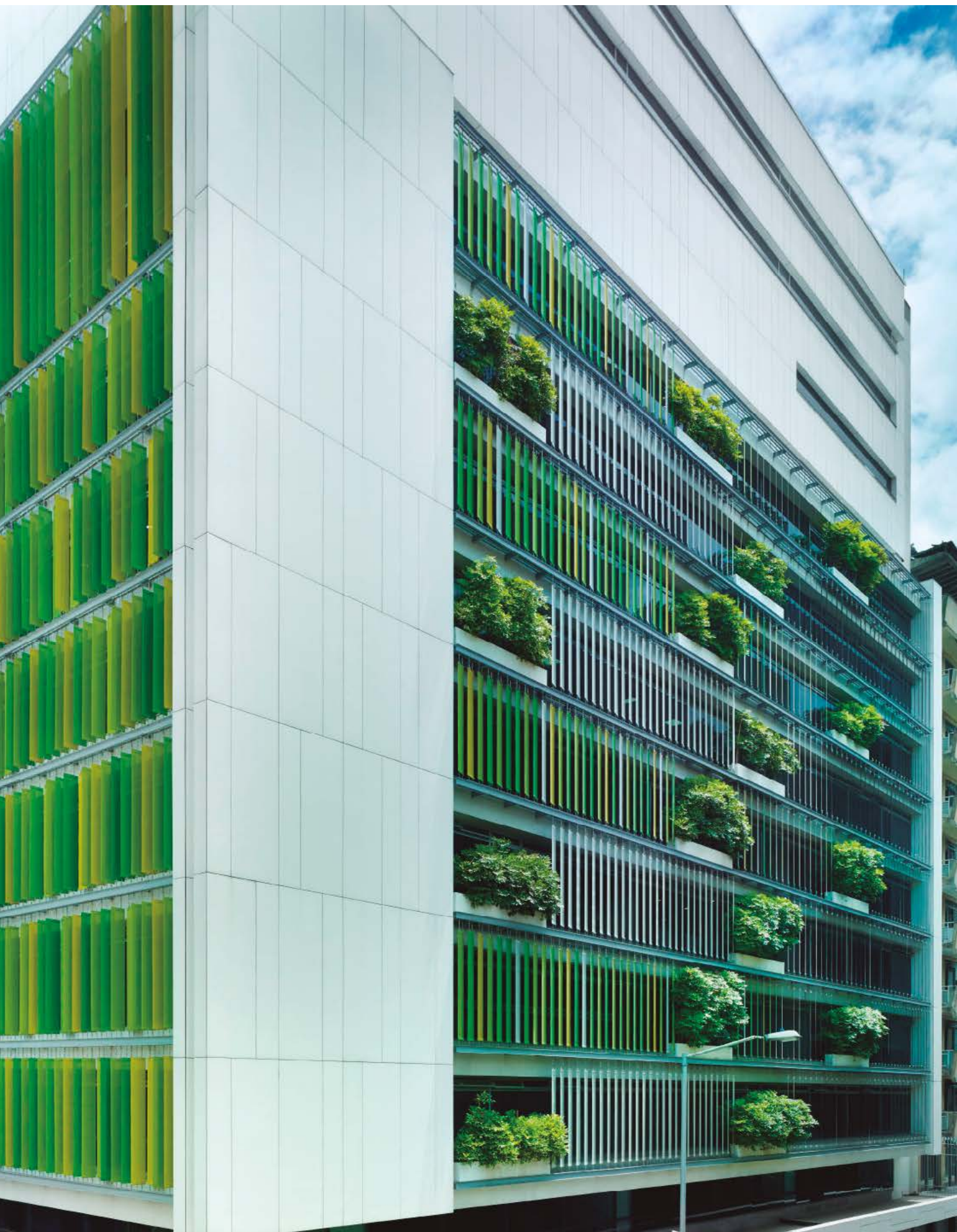
FUNDACIÓN UNIVERSITARIA AUTÓNOMA DE LAS AMÉRICAS Arquitecto: Santiago Maestre Carmona - Productos: Stripscreen, Cielos B
