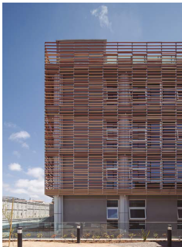
Centro Judicial, La Serena - Arquitecto: Fermín Bustamante Productos: NBK Baguette, AeroScreen Plus, Deck Bamboo Xtreme Imagen portada: Campus Creativo Bellavista, UNAB - Arquitectos: Martín Schmidt Radic Arquitectos Asociados - Producto: QuadroLines 30x15
