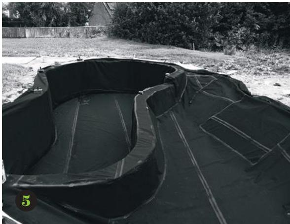
La membrane est posée directement sur le feutre de protection. La forme 3D épouse parfaitement la structure.
