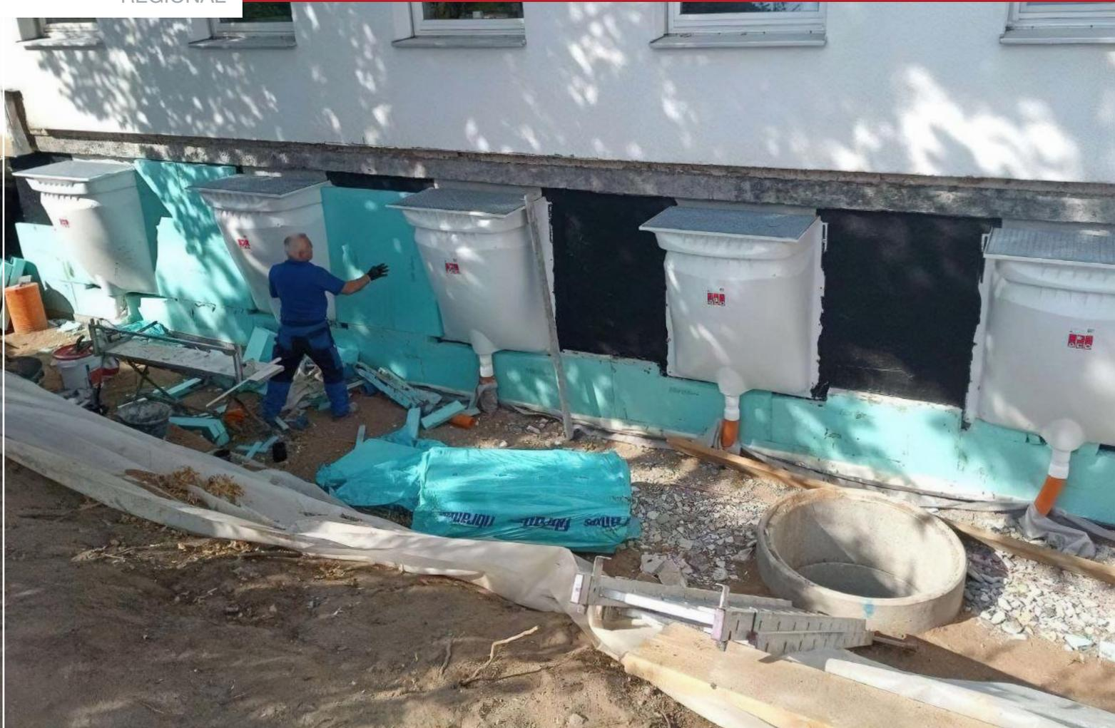
Vertikale Abdichtung mit bituminöser Dickbeschichtung und Perimeterdämmung
