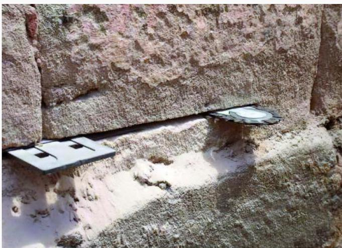
Mauersägeverfahren: Zuerst wird das Mauerwerk abschnittsweise aufgeschnitten.
