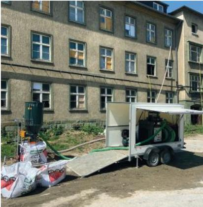
Absaugung des Fräsguts nach außen
