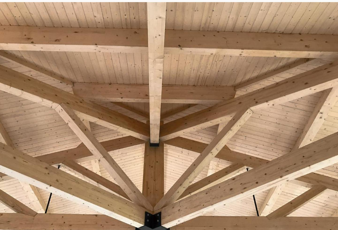
Esta cubierta de madera laminada de abeto está concebida a partir de cerchas tradicionales que sirven de apoyo para las distintas correas que se extienden a lo largo de las pendientes. Sobre estas se colocan paneles prefabricados de machihembrado que incorporan aislamiento en su interior para mejorar el comportamiento energético del espacio.
