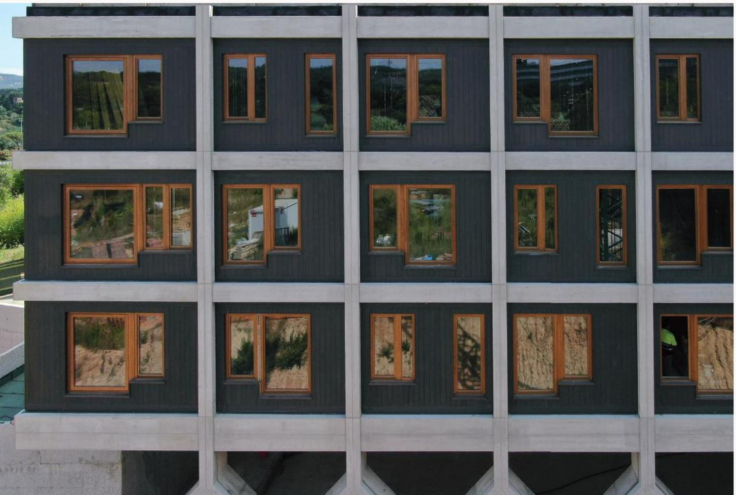
Este hotel, situado a pocos kilómetros de Barcelona, cuenta con un sistema mixto que combina una estructura de hormigón y una envolvente a partir de muros prefabricados de entramado ligero. Estos muros ofrecen una alta eficiencia energética gracias a su aislamiento interior de lana mineral. En el exterior, la fachada es ventilada y revestida con madera termotratada (Thermowood), que resiste las condiciones de la intemperie.
