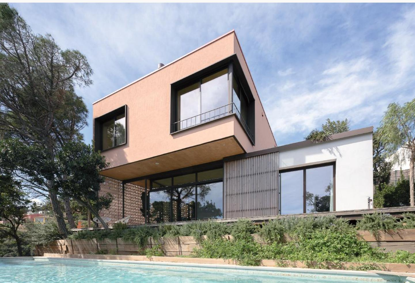
Ubicada sobre una pendiente pronunciada, esta casa ofrece espectaculares vistas al mar Mediterráneo. Su diseño se basa en los estándares "passivhaus" mediante el sistema constructivo de entramado ligero. La fachada está revestida con un sistema SATE y acabada con mortero de cal en tono tierra, que se integra armoniosamente con el entorno natural.
