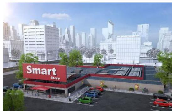
Se espera que la tienda sea un 50% más eficiente en términos energéticos que una tienda tradicional, el 90% de las necesidades de calefacción de toda la tienda será proporcionada por una unidad de recuperación de calor que captura el exceso de calor producido por los sistemas de refrigeración. El supermercado cuenta con dos sistemas de refrigeración que funcionan de forma independiente, lo que garantiza que las pruebas del producto no interfieran con las operaciones del supermercado.
