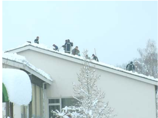
Dachabschaufeln bei der Volksschule Pierbach
