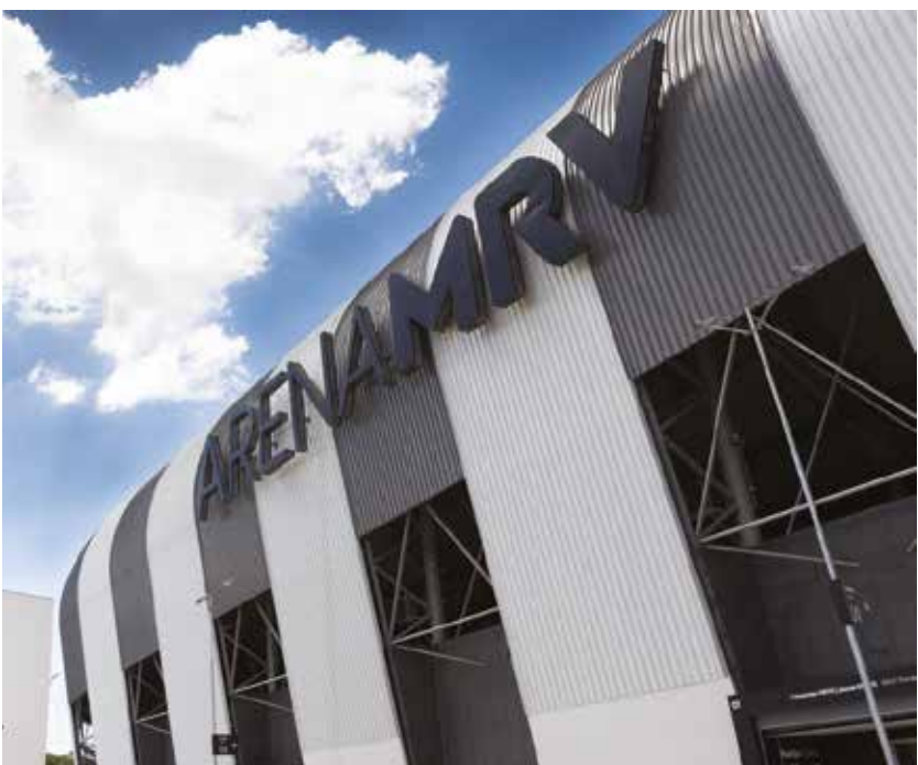
Obra: Arena MRV - Belo Horizonte MG Instalador: JAM Engenharia
