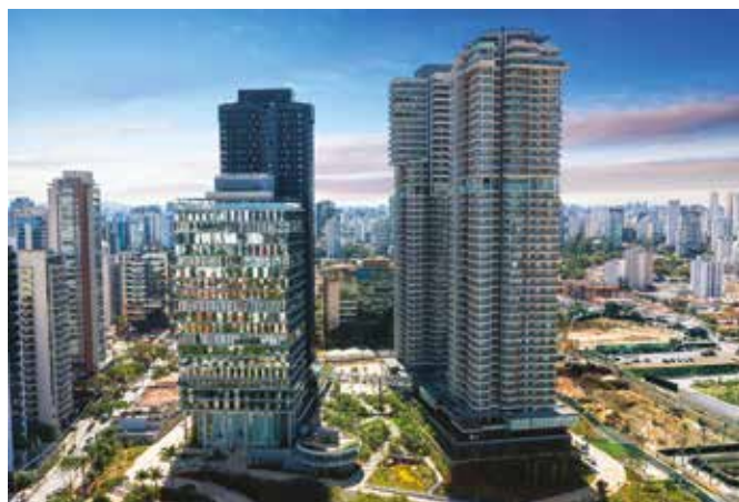
Obra: Conjunto Comercial O Parque - São Paulo SP Instalador: Best Clima Engenharia e Instalações
