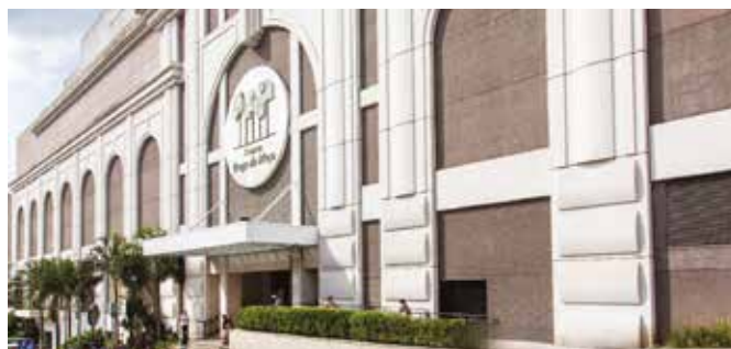
Obra: Shopping Praça da Moça - Diadema SP Instalador: SET Sociedade de Engenharia Térmica
