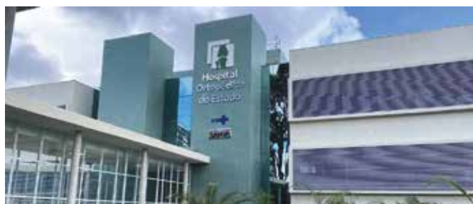
Obra: Hospital Ortopédico do Estado - Salvador BA Instalador: Artemp Engenharia Térmica
