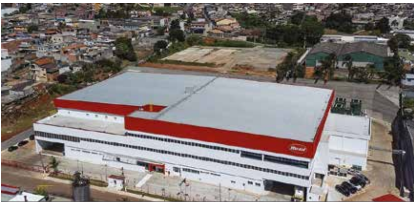
Obra: Fábrica de Chocolates Harald - Santana do Parnaíba SP Instalador: Newset Tecnologia em Climatização
