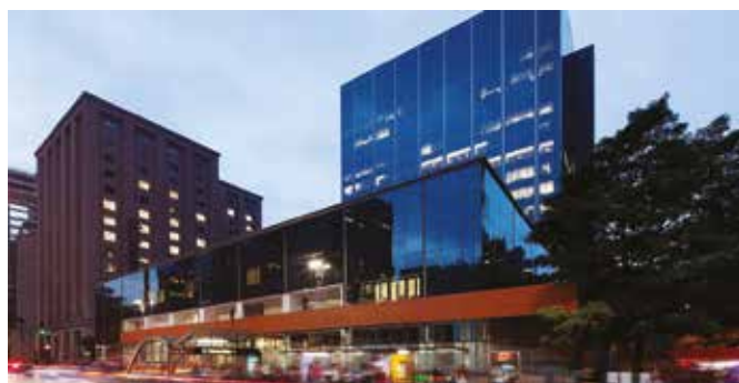
Obra: BFC Corporate Building Retrofit - São Paulo SP Instalador: Star Center Soluções em Climatização
