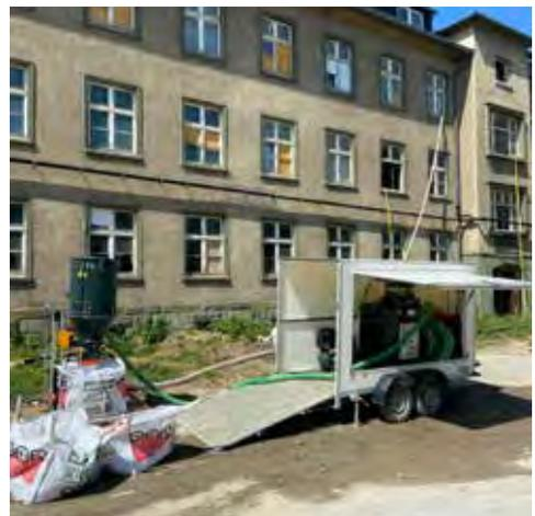
Geräteset für den Einsatz eines anerkannten emissionsarmen Verfahrens für Abbruch-, Sanierungs- und Instandhaltungsarbeiten an Asbestprodukten nach DGUV Information 201-012 (bisher BGI 664).
