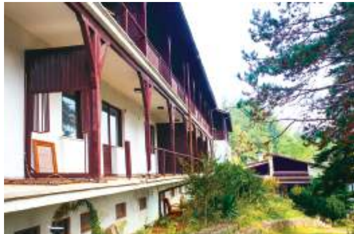
38. Çınar Otel'i zemin katındaki 16 adet banyonun dıştan görünümü. Foto: Serhat Gökçaylar
