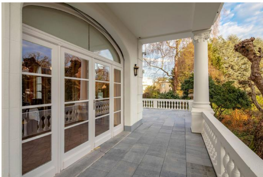
En la renovación de la villa de estilo Art Nouveau se sustituyeron las ventanas originales por 30 unidades fabricadas con vidrio aislante al vacío FINEO de AGC.
