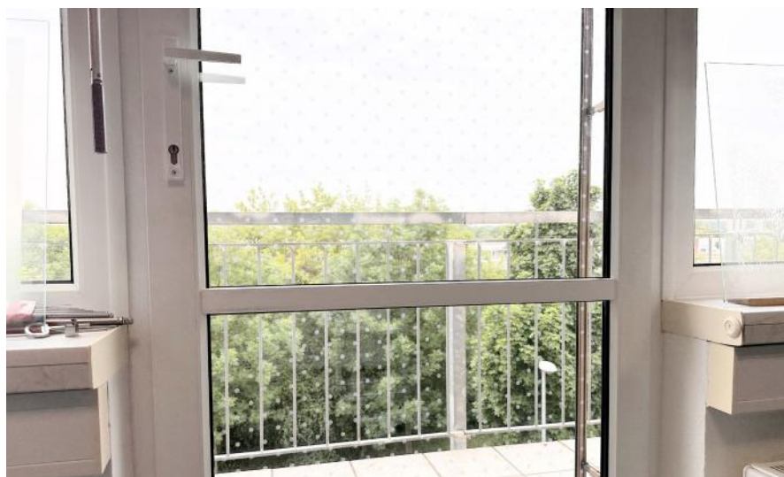
De forma personalizada y adaptada a las propiedades del vidrio, se imprime un patrón de protección contra aves, ya sea parcialmente transparente u opaco.
