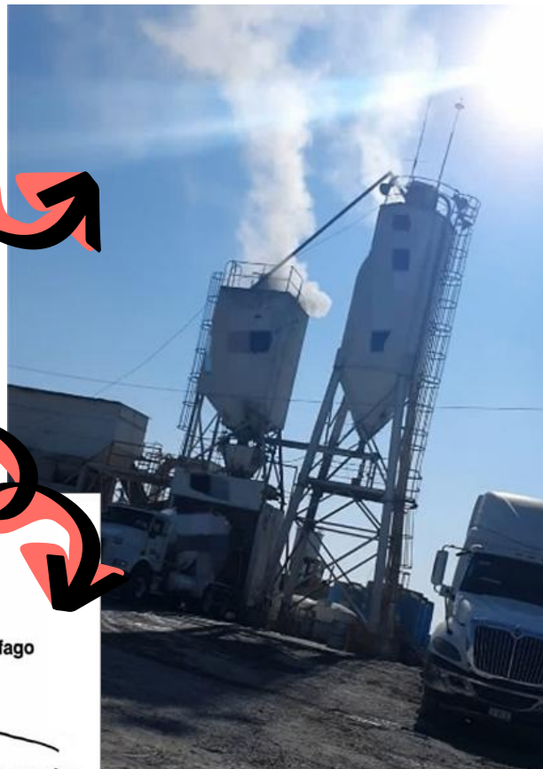
Figura 2. Emisiones fugitivas en silo de almacenamiento de cemento, dentro de una planta de concreto.
