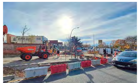
Des travaux de finition sont prévus jusqu'en avril dans le boulevard Diancourt. © l'Hebdo du Vendredi
