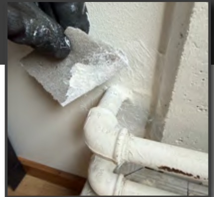
Patteriputken läpivienti
