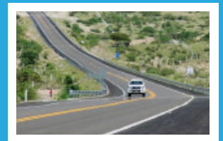
AUTOPISTA OAXACA - ISTMO DE TEHUANTEPEC.
