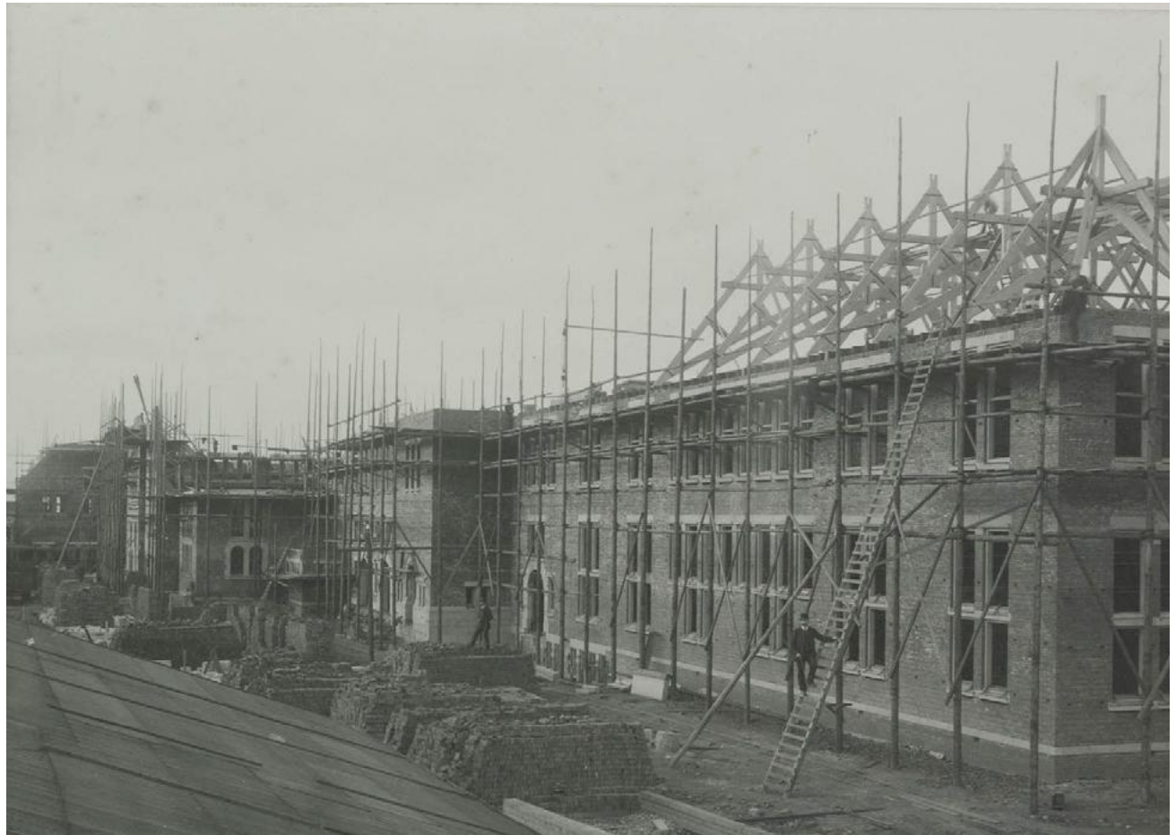
Bouw van het station, 1914. [GVN]
