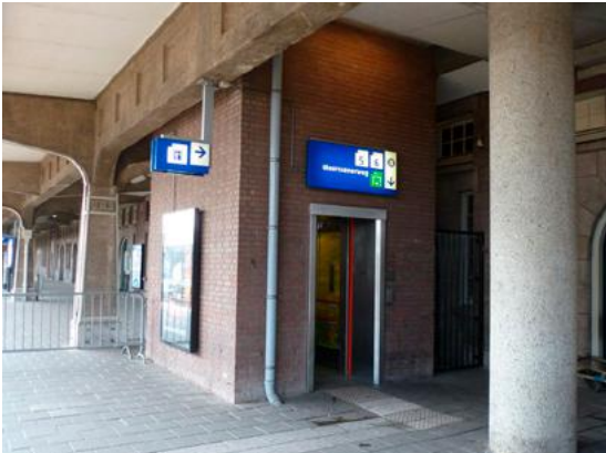
Lift van de voetgangersbrug in het langsperron.
