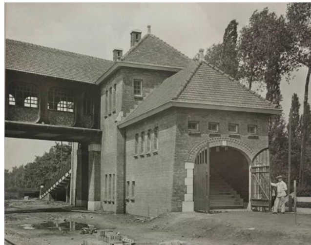
Toegang tot de voetgangersbrug aan de stationszijde, omstreeks 1916. [GVN]
