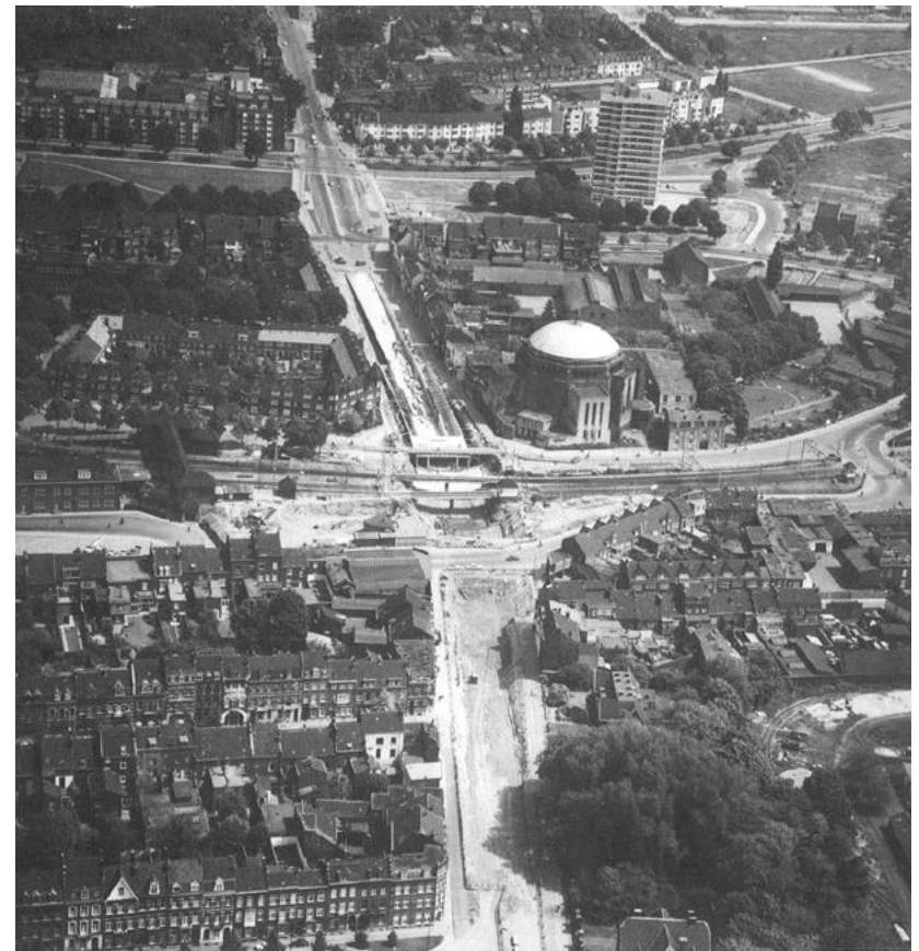
Bouw van de tunnel Akerstraat-Scharnerweg omstreeks 1961. [Boogaard, 1982]
