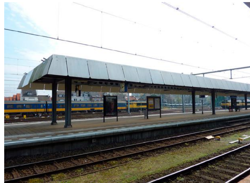
Perronoverkapping van het perroneiland (ontwerp C. Douma, 1985) aan de oostzijde van het stationsgebouw.
