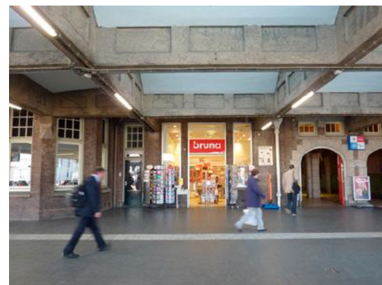
Verlengde vensteropeningen in de noordgevel naast de doorgang.
