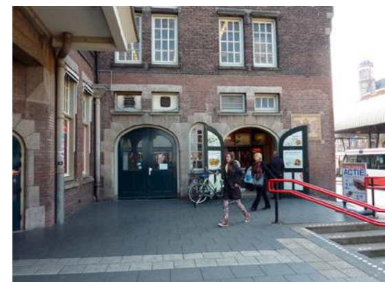
Noordgevel ter hoogte van de voormalige visitatiezaal. Het kleurverschil in het metselwerk laat zien waar vroeger de perronkap zat.
