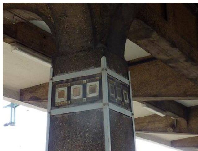
Detail van de betonnen kolom.
