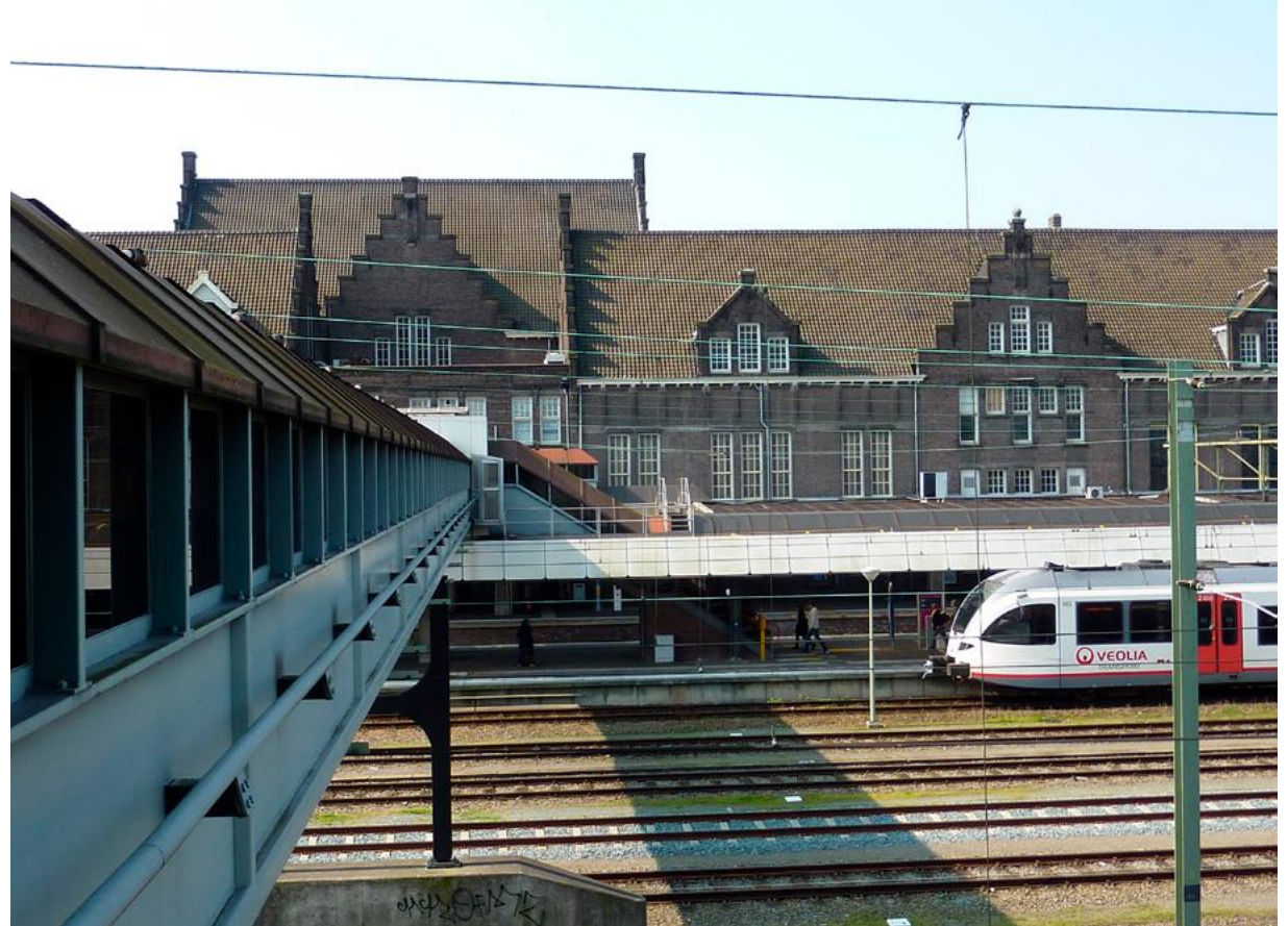
Perrongevel en voetgangersbrug.
