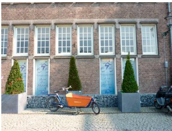
Verlengde vensteropeningen in de voorgevel ter hoogte van de fietsenstalling.
