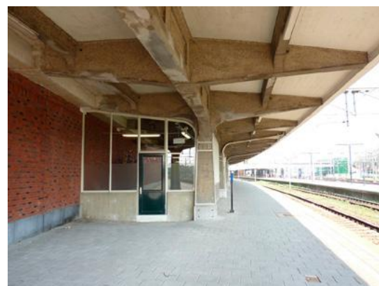
Uitbouw van de fietsenstalling in het langsperron.
