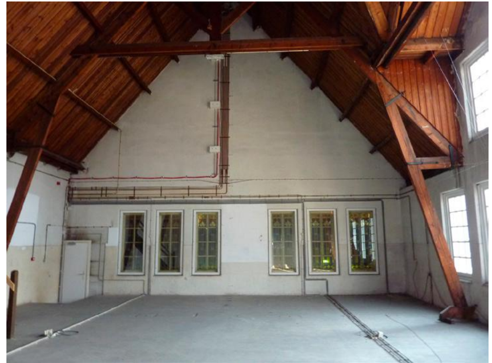
Zolderruimte eerste verdieping boven de hal.
