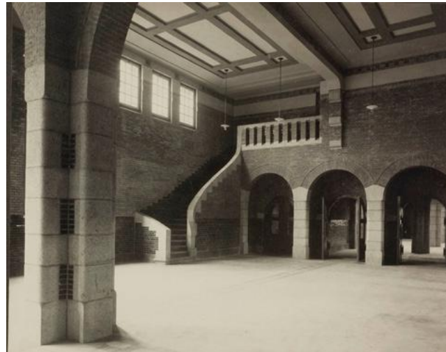
Hal met doorgang naar de koppersperron., 1915. De trap geeft toegang tot de eerste verdieping (bergruimte boven hal en boven de restauratie wachtkamer 1ste en 2de klasse). [GVN]
