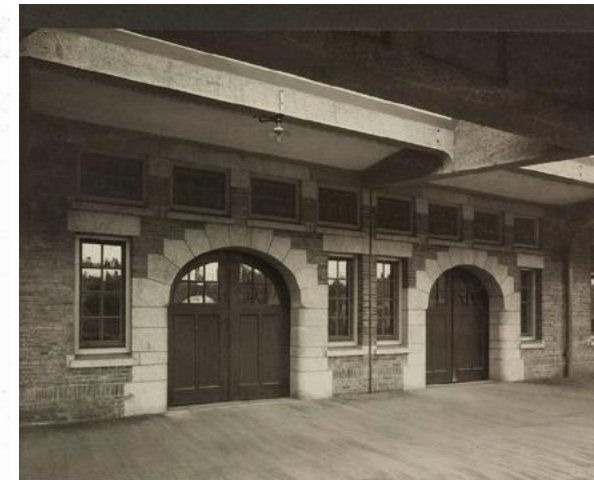
Toegangsdeuren van de goederenruimte vanaf het langsperron, omstreeks 1915. [Bureau Spoorbouwmeester]
