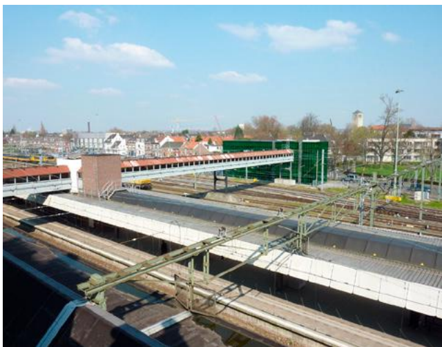
De huidige voetgangersbrug achter het stationsgebouw (ontwerp C. Douma).
