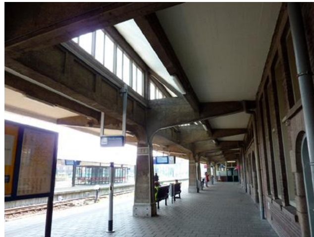
Sheddaken in de perronkap van het langsperron.
