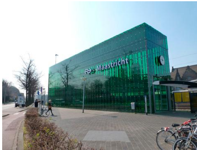
Ingang van het station aan de Meerssenerweg
