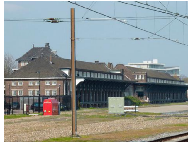
Goederen en douaneloods uit 1915.
