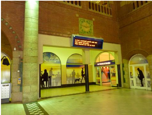
Ingang kaartenverkoop NS. Hierbij zijn de drie kolommen zichtbaar van de muurdoorbraak uit 1979.
