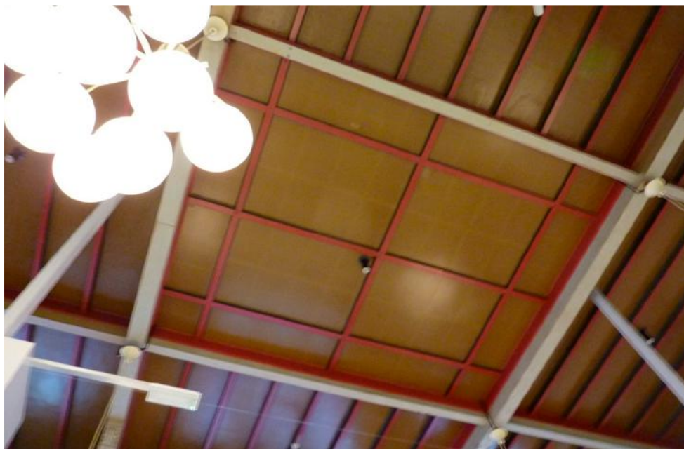
Plaatwerk waarboven zich het oorspronkelijke glas-in-lood plafond bevindt in de Albert Heijn.
