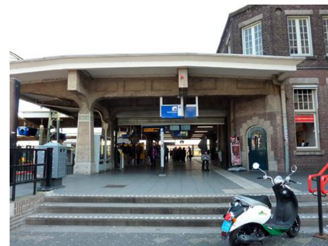
Zicht op perronoverkapping vanaf het busstation. Hier is een deel van de perronkap gesloopt.
