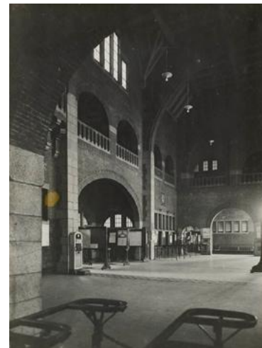
De vestibule gezien vanaf de doorgang naar de hal, 1915. [GVN]
