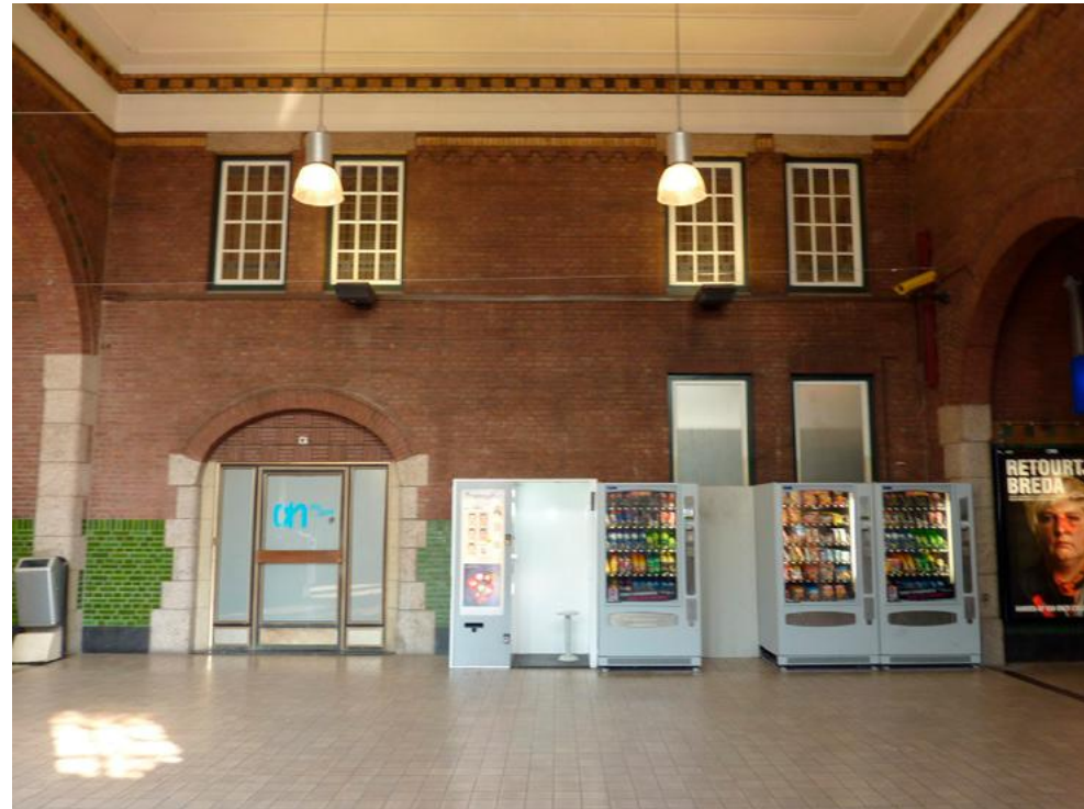
Zicht op een van de entrees van de voormalige wachtkamer 3de klasse (nu Albert Heijn) vanuit de hal. De toegang is omstreeks 1960 vernieuwd (opening kleiner en nieuwe deurkozijn). De foto- en drank automaten langs de wand zijn voor de ramen gezet.
