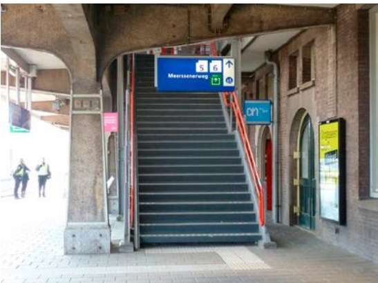
Trap naar de voetgangersbrug in het langsperron.
