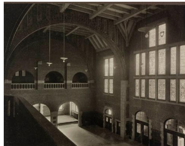
De vestibule gezien vanaf de personeelsgalerij, 1915. [GVN]
