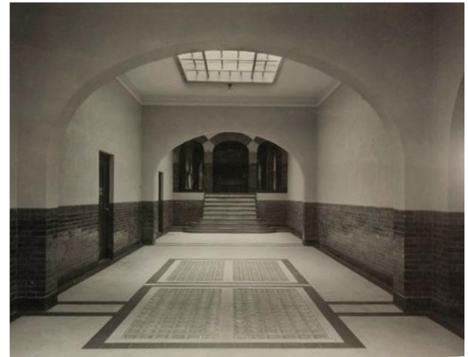
Personeelsgalerij op de eerste verdieping ter hoogte van de goederenruimte op de begane grond, 1915. Op de vloer zijn glazen bouwstenen opgenomen ten behoeve van de daglichttoetreding van de goederenruimte. [GVN]
