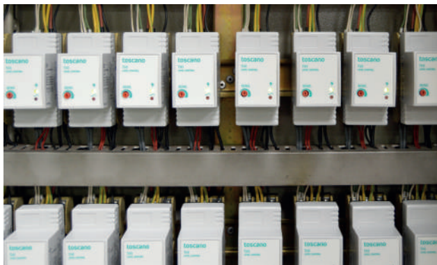
Banco de test de hidroneveles TH
