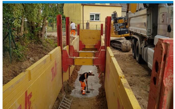
Baugrubenverbau für Sedimentationsanlage
