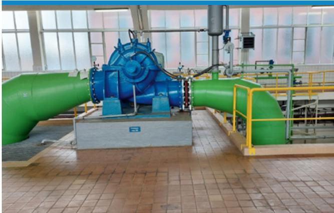
Brauchwasserpumpe mit Saug- und Druckleitung
