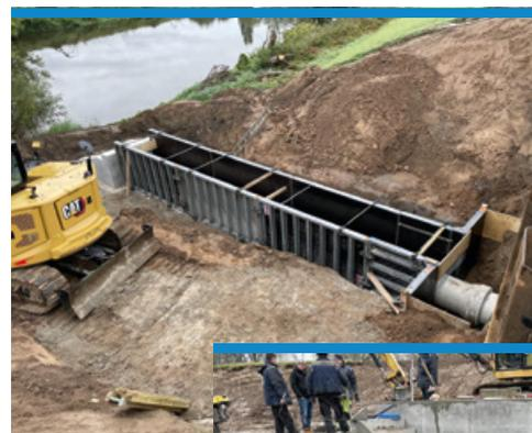
*Einbau der wasserseitigen Siel-Rohrleitung*
