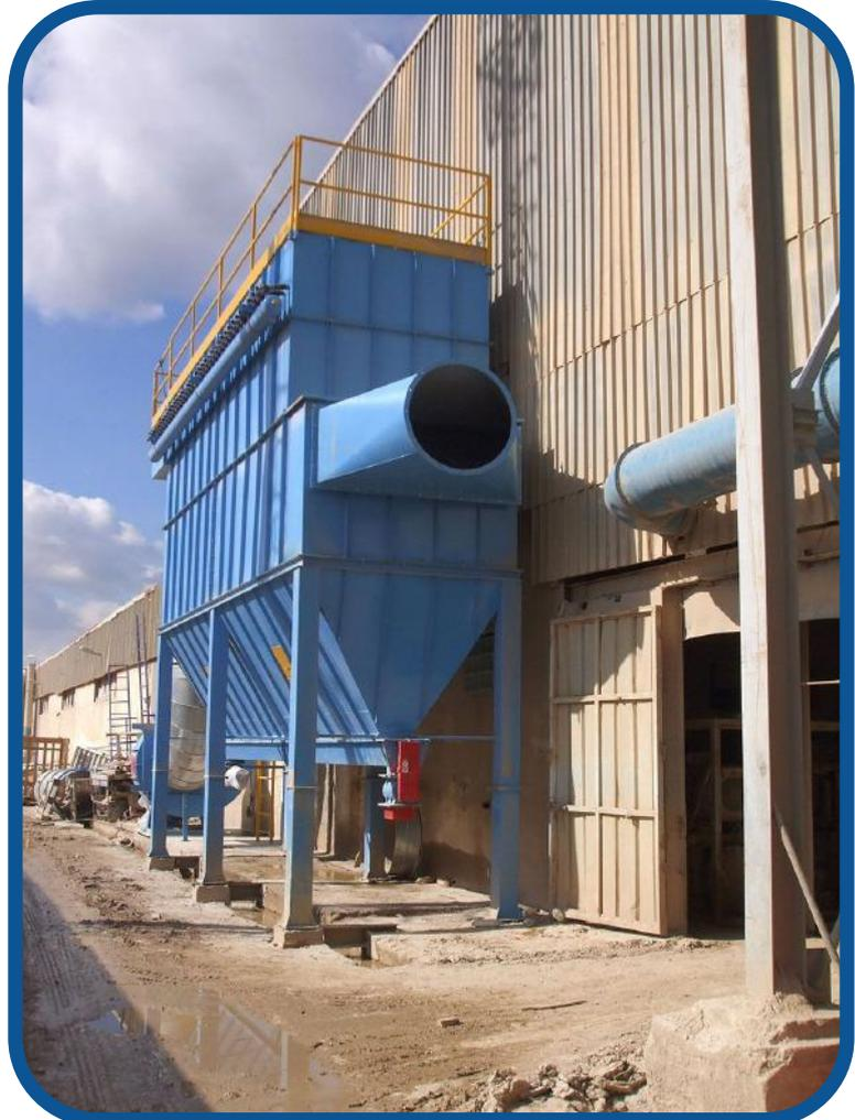
🇮🇹 I depolveratori a cartucce sono nati come alternativa ai tradizionali filtri a maniche in quanto permettono, a parità di dimensioni, una superficie filtrante 20 volte maggiore. In funzione alla tipologia di polvere da trattare, sono disponibili cartucce con dimensioni e caratteristiche differenti, in modo da coprire un'ampia gamma di esigenze.
