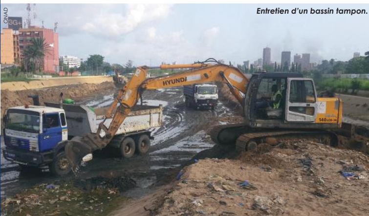
Entretien d'un bassin tampon.
