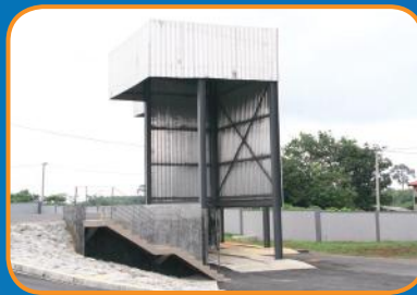
Construction du centre de groupage de Namoué (Commune de Bingerville)
