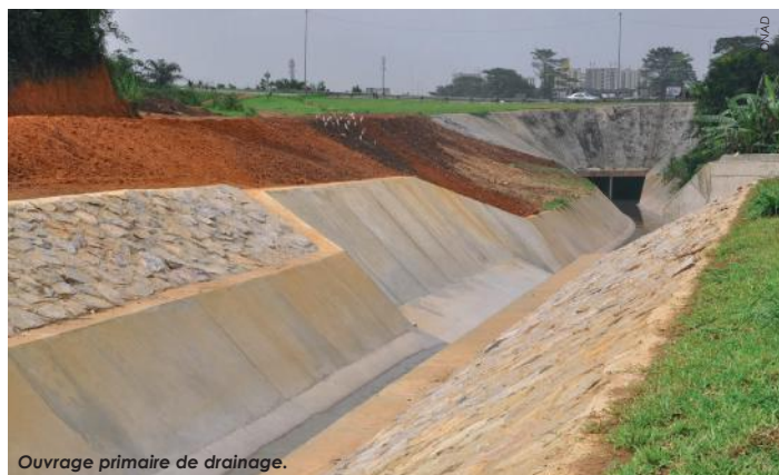
Ouvrage primaire de drainage.
