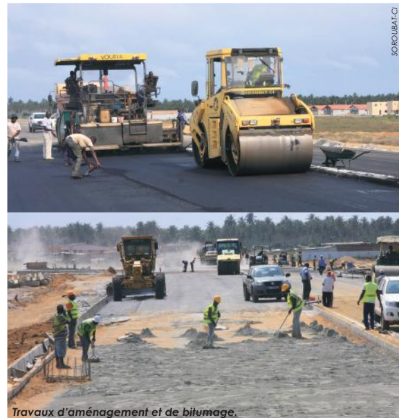
Travaux d'aménagement et de bitumage.
