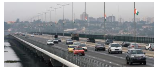
110 – INFRASTRUCTURES La BAD débloque 770 millions d'euros pour les infrastructures routière d'Abidjan
