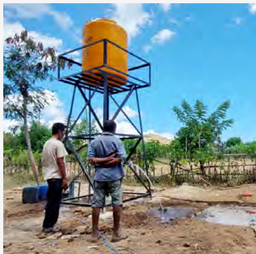
Proses pembangunan sumur bor dan bak penampungan
