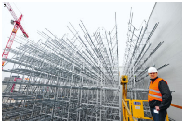
1 Die Hebebühne als täglicher Begleiter. Installation der Gitterkanäle für die Brandmeldeanlage
