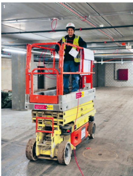
1 Die Hebebühne als täglicher Begleiter. Installation der Gitterkanäle für die Brandmeldeanlage
