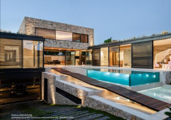
Edificio H60 HOUSE, premiado en el 23º Concurso Internacional METRA BUILDING.
