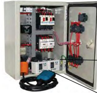
Todo ensamblado y cableado listo para instalarse
