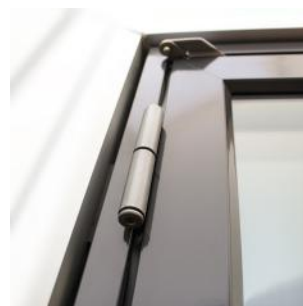
Adjustable hinge, terrace door
