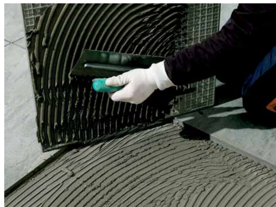
STENDERE L'ADESIVO IN MODO OMOGENEO SECONDO LA TECNICA DELLA DOPPIA SPALMATURA (SIA SUL FONDO CHE SUL RETRO DELLA PIASTRELLA)
