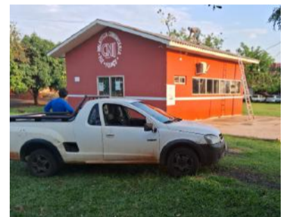
Restauração do telhado da biblioteca
