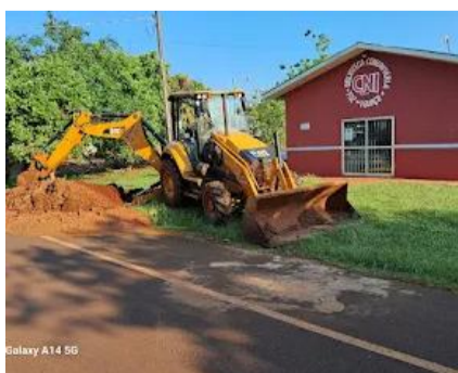
Manutenção e reparo da biblioteca
