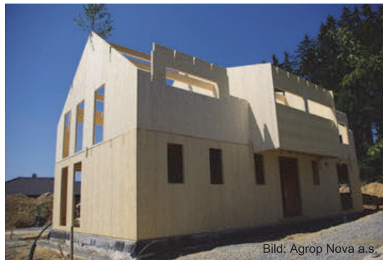
Abb. 69: Rohbau im Holzmassivbau mit Brettsperrelementen. Es sind alle individuellen Gebäudeformen erstellbar.
