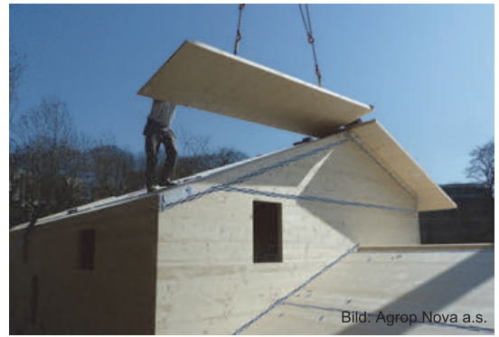
Abb. 70: Selbst Dächer können hergestellt werden.
