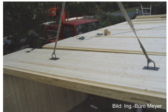
Abb. 71: Eine große Zukunft haben die Brettsperrelemente für die horizontalen Bauteile wie Flachdächer und Geschossdecken. Die Bauzeiten verkürzen sich um Wochen.
