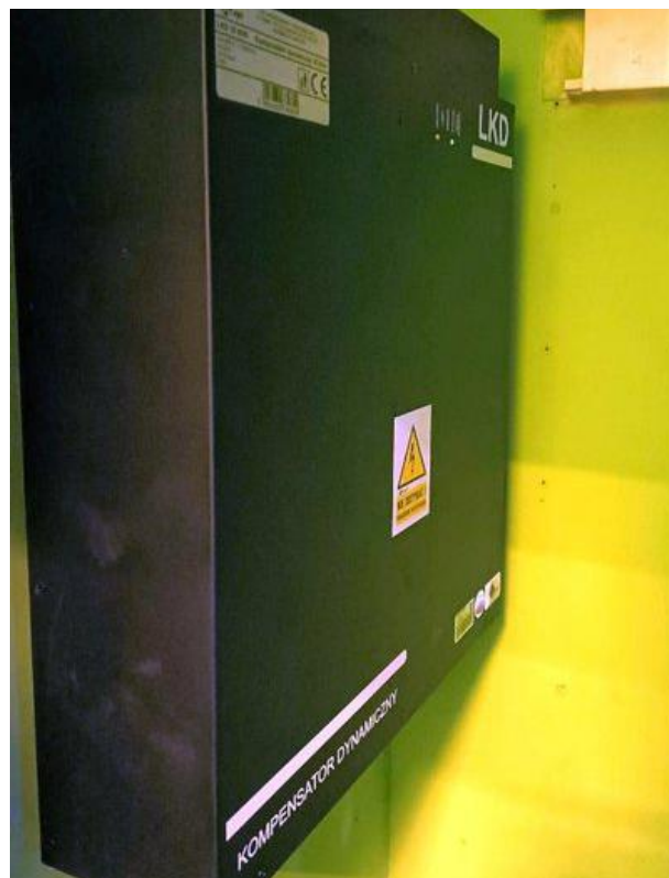
Fig. 8. Compensador LKD15 instalado en el edificio analizado
