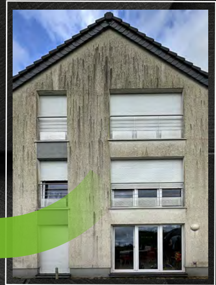
TAFF Fassadebotz zu Wuelessen
