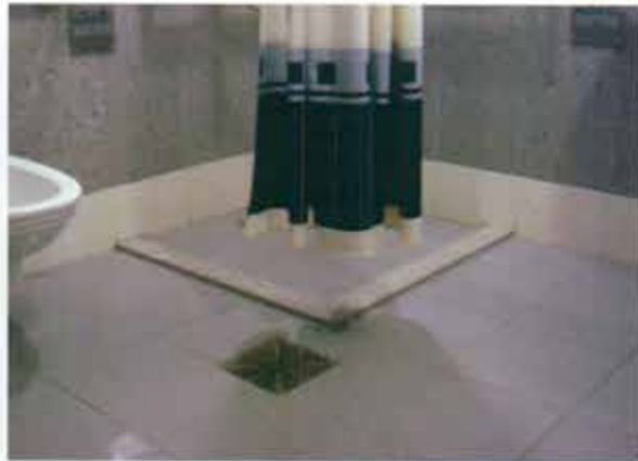
دورة مياه في الطابق النموذجي
