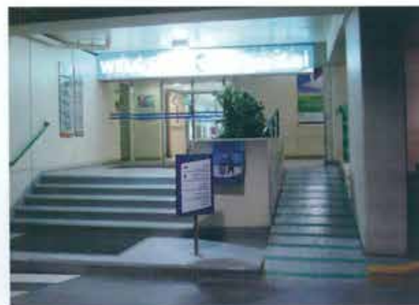
درجات سلالم ومنحدر لمدخل المستشفى
