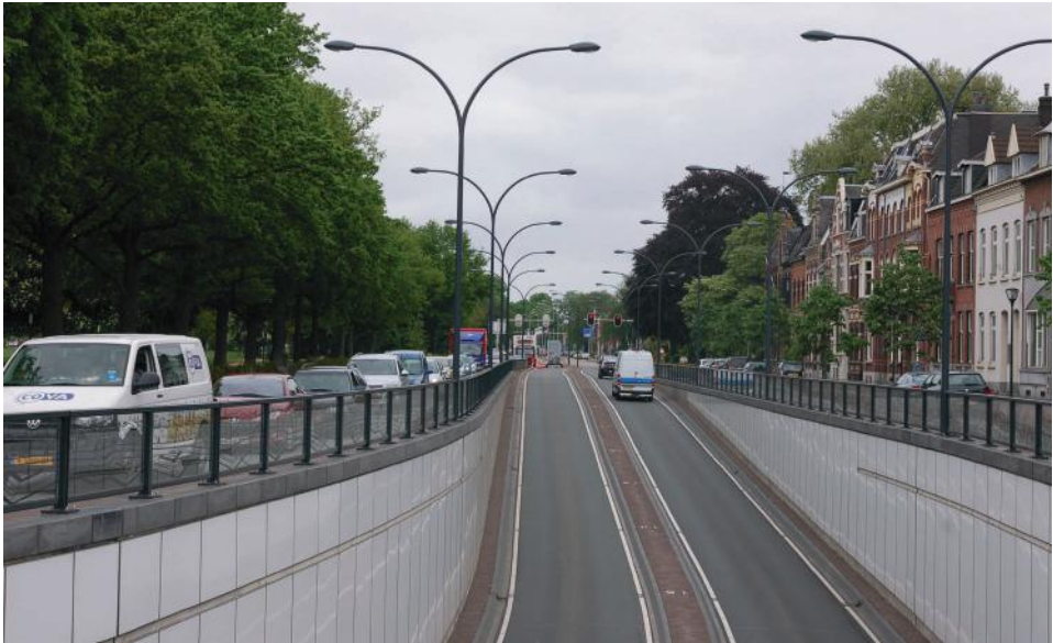
nieuwe verkeerstunnel onder Koninginneplein, 2013
