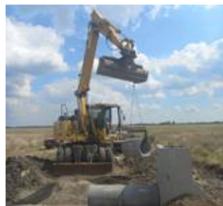
Zsilipes átereszt építés közben Fotó: Pataki Zsolt
