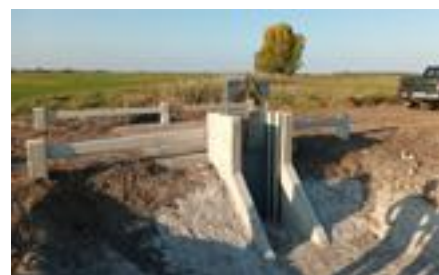
A földutat keresztelő zsilipes átereszt a vízvezetés, illetve vízmegtartás szabályozására szolgál. Fotó: Pataki Zsolt
