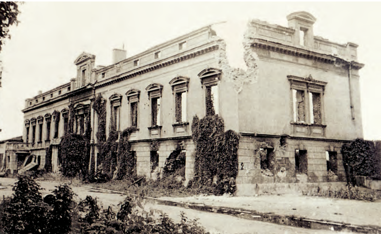
Budynek Pokuratorski (zniszczenia z 1939 r.)
