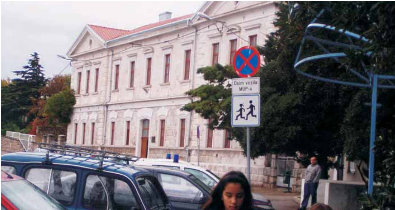
Zgrada Osnovne škole Karlobag
