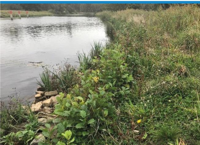
Abb.: Mit beplanten Kokoswalzen gesicherte Uferböschung und ein sich selbstständig entwickelnder Erlensaum am Altarm 2, Foto vom 28.09.2021
