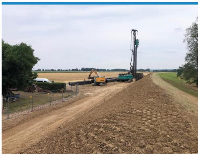
Abb.: Einbau Spundwandsonderlösung (TO2)
