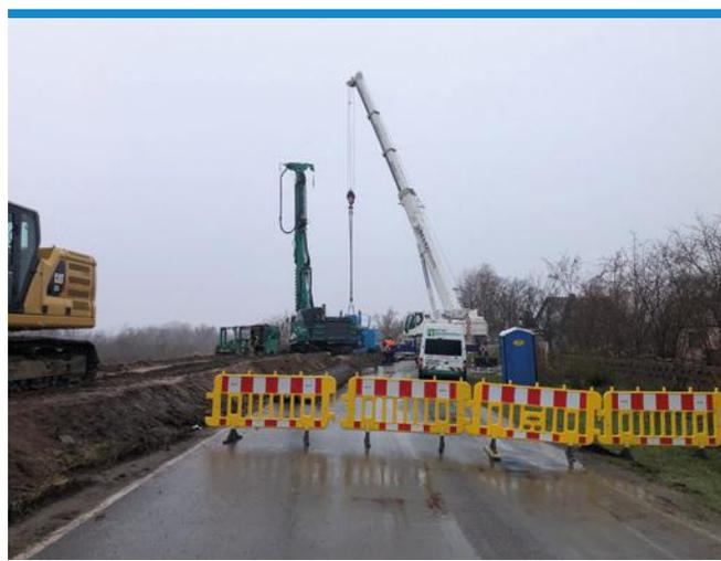
Abb.: Proberammung (TO3)
