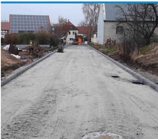
Abb.: Zustand vor Asphaltteinbau
