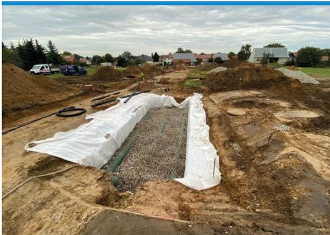
Abb.: Eingebaute Versickerungsrigole
