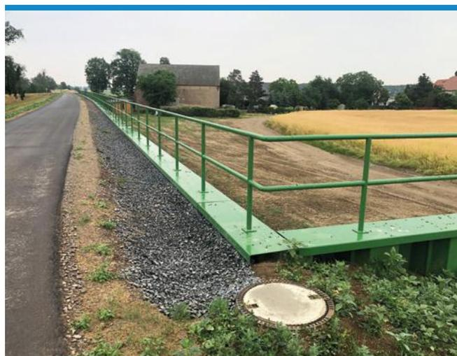
Abb.: Spundwandbereich nach Fertigstellung (TO2)
