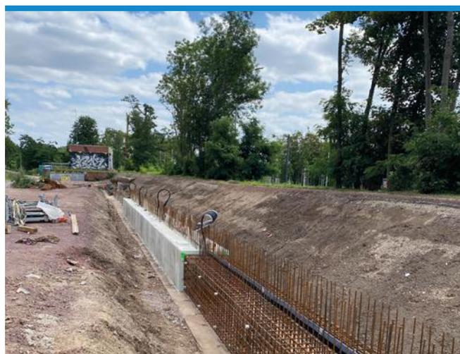
Abb.: Bewehrungs- und Betonarbeiten
