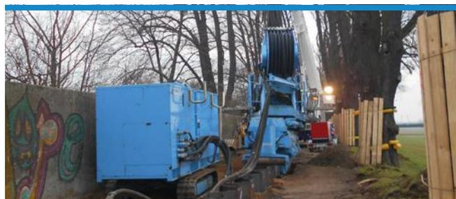
Abb.: Spundwandeinbau mit dem GRB-System
