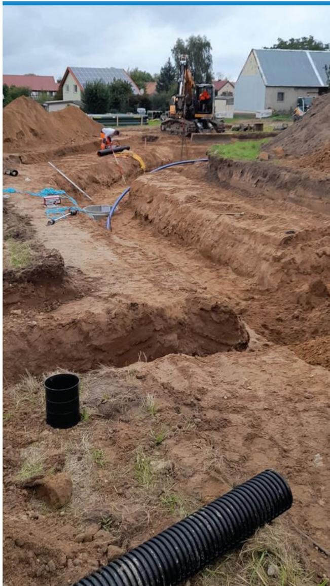
Abb.: Verlegung Schmutz- und Trinkwasserleitungen
