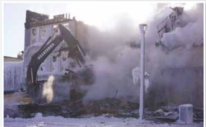
Lethbridge Hotel demo. Ossa Terra Ltd.
