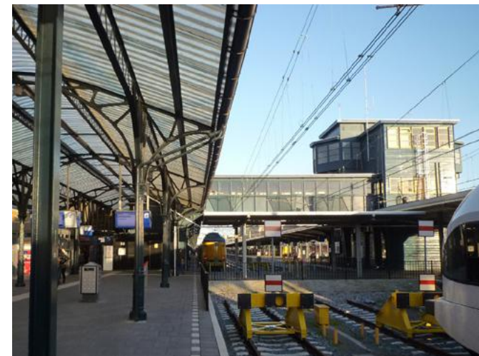
Afb. 4.82: De traverse en het seinhuis vanuit het westen
