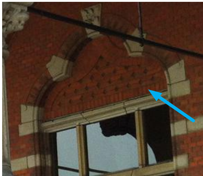
Afb. 4.40: Het metselwerk in de boogvelden van de westelijke (personeels)vleugel
