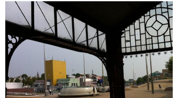
Afb. 4.62: Het vakwerkspant van de luifel boven de ingang
