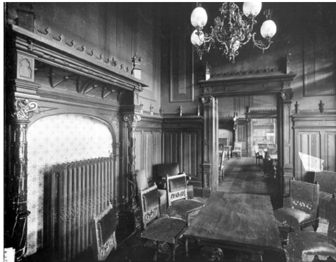
Afb. 4.15: Doorkijkje vanuit damessalon naar wachtkamer en restauratie
