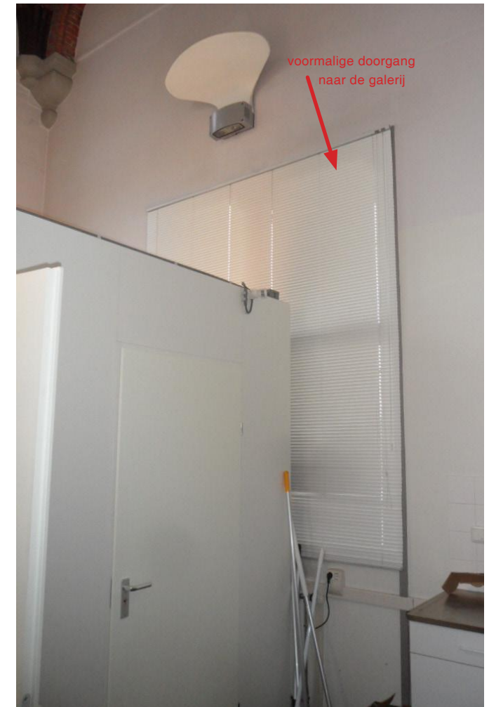
Afb. 4.61: Huidige inrichting oostelijk tochtportaal (opslagruimte)
