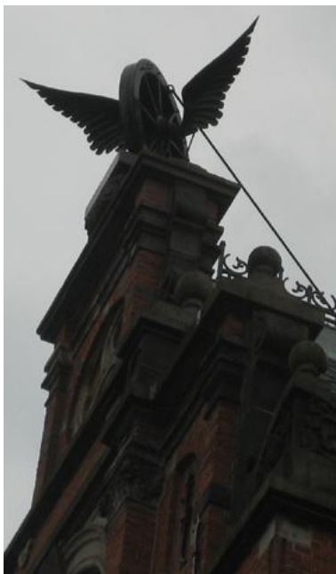
Afb. 4.34: Het gevleugelde wiel op het middenpaviljoen (A)
