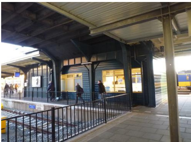
Afb. 4.78: De noordzijde van de onderbouw op het 3e perron
