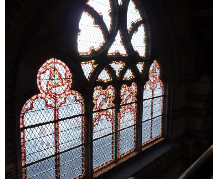
Afb. 4.38: Het venster in de achtergevel van de vestibule
