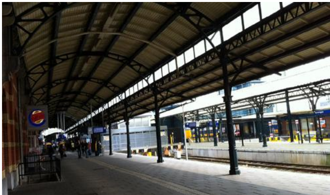
Afb. 4.60: Hogere kap voor het gebouw en ventilatiestrook
