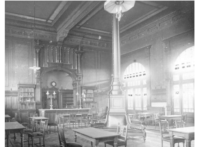
Afb. 4.42: De onderaan betimmerde kolom van kwadrant-ijzer
