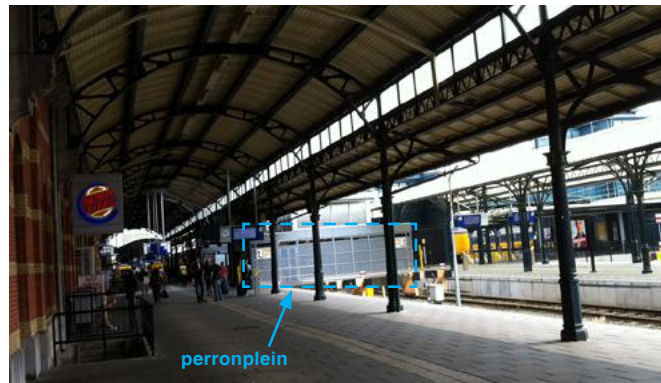
Afb. 4.84: Oorspronkelijke toestand zonder daklicht en perronplein
