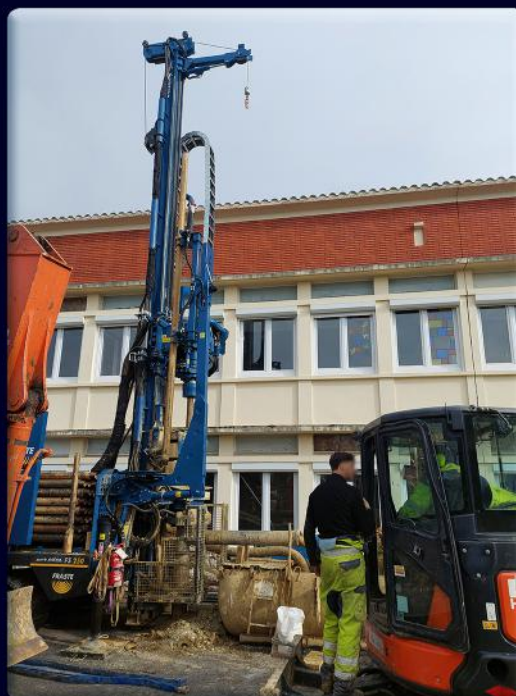
Réalisation d'un forage
