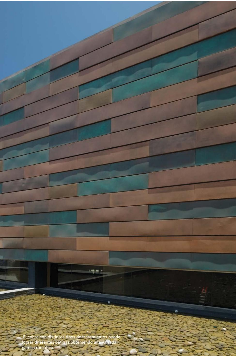
El cobre con distintos tipos de tratamientos puede lograr diferentes patinas obteniendo una variada gama cromática.
