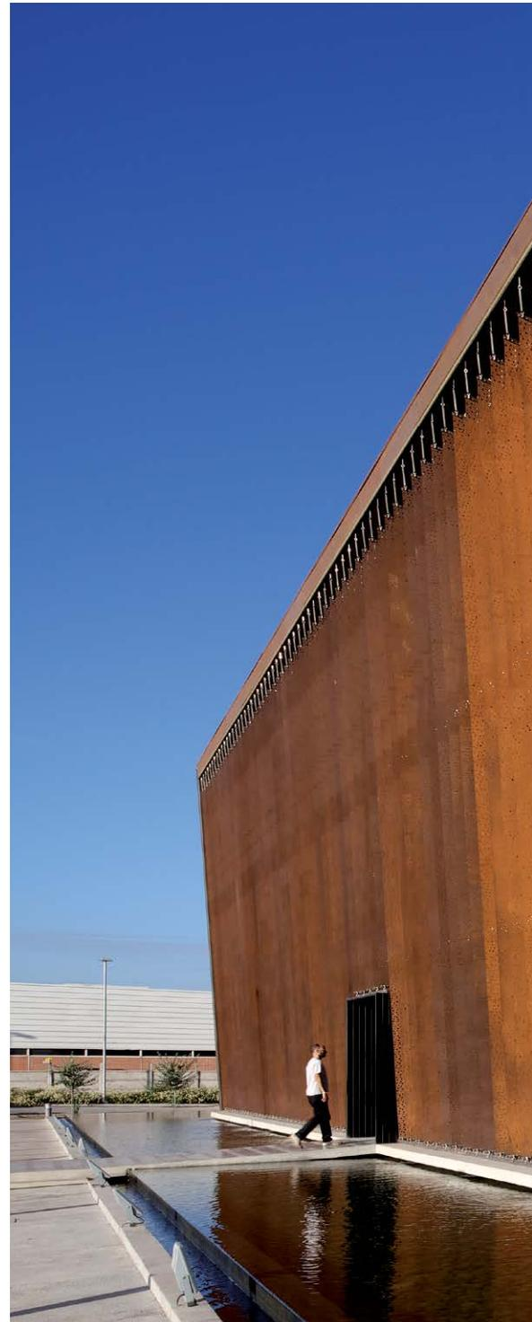
El acero corten es un material que tiene como característica las distintas tonalidades rojizas que toma a través de un proceso de oxidación controlada realizado en nuestra planta productiva. A medida que pasa el tiempo, la oxidación va permitiendo que el material se autoproteja, es decir, crea una película de óxido impermeable al agua que evita que ésta ingrese, desacelerando el proceso de oxidación.
