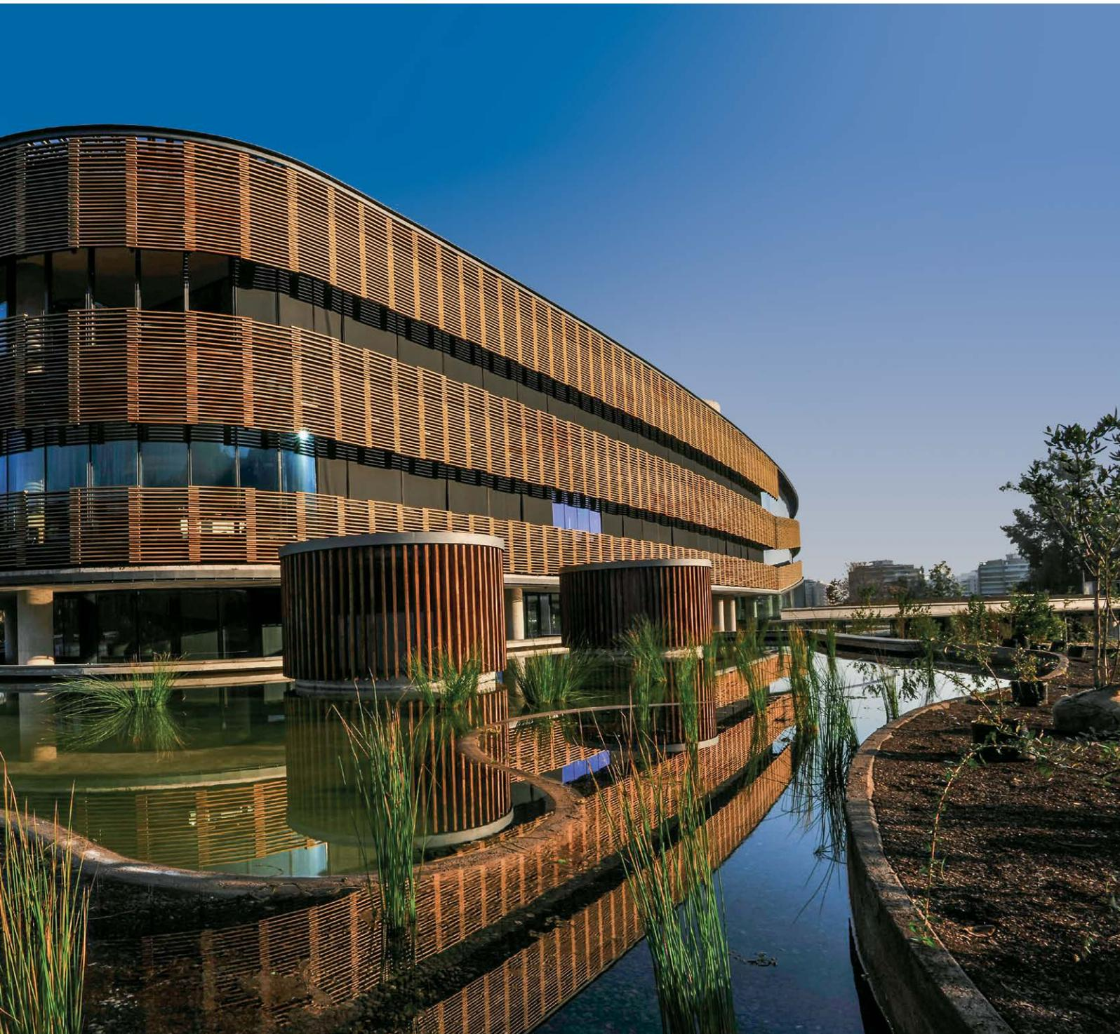
El cielo Woodlines está compuesta por una chapa de madera natural adherida a un perfil metálico formado, con lo cual se obtiene un producto de gran calidez y fina terminación con toda la funcionalidad de un cielo lineal metálico Hunter Douglas. Esta línea de productos por su composición, proporcionan la calidez propia de la madera sin requerir ningún tipo de mantenimiento, asegurando una alta durabilidad, estabilidad dimensional en el tiempo y una muy fácil limpieza.
