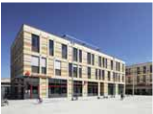
EVER.S am Oertelplatz, München. Architects: nps Bauprojektmanagement GmbH, Ulm
