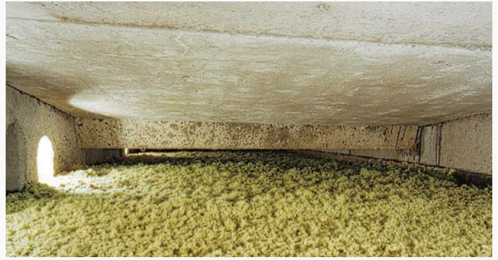
Nichtbrennbare Steinwolle in Flockenform für offene und geschlossene Konstruktionen; Bestandteil des ROCKWOOL Einblasdämmsystems.
