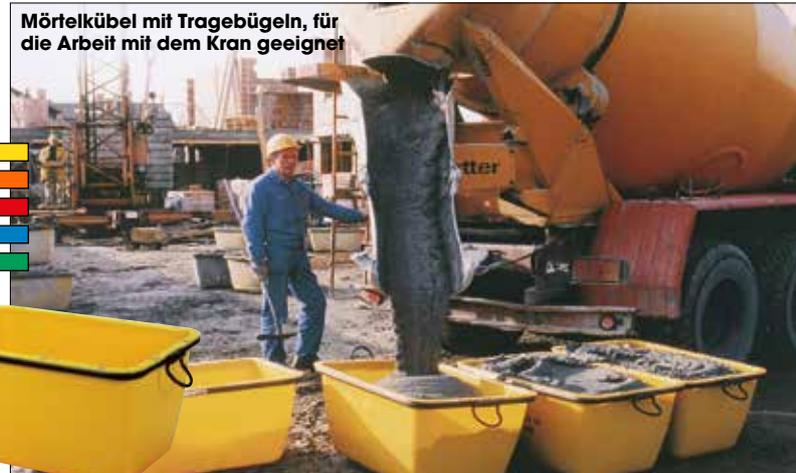
Mörtelkübel mit Tragebügeln, für die Arbeit mit dem Kran geeignet
