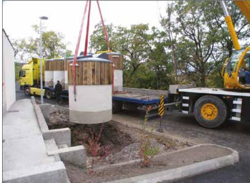
*Einbau von Tiërso-Systemen in Gap (Frankreich); nach dem Verfüllen der Baugrube ist das System einsatzbereit.*
