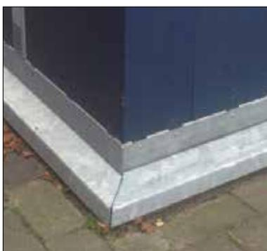
**Ein Profil dichtet die Fuge zwischen Sockelbehälter und Container ab, sodass weder Sand noch Blätter hineingeht werden können.**
