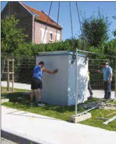
**Der Betonschacht wird in die vorbereitete Baugrube eingelassen.**
