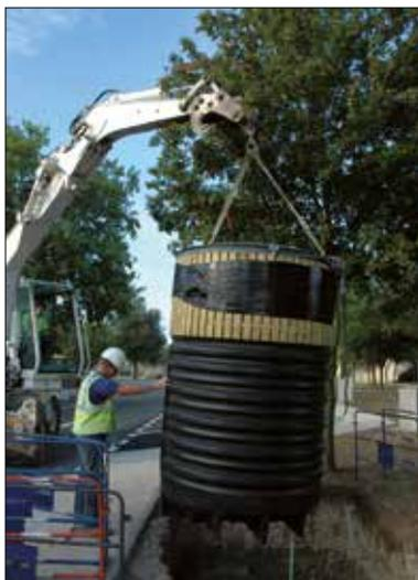
**Einfach und schnell mit einem Bagger aufstellbar.**
