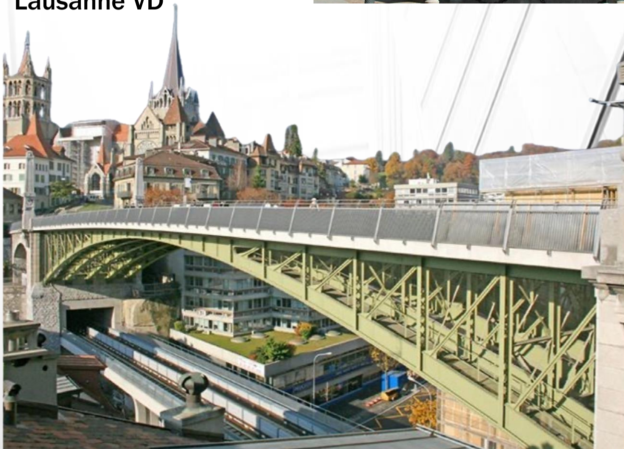
Le pont Charles Bessières à Lausanne VD
